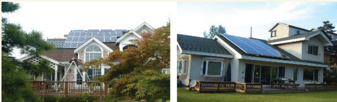
< 태양광 주택 설치 예 >
